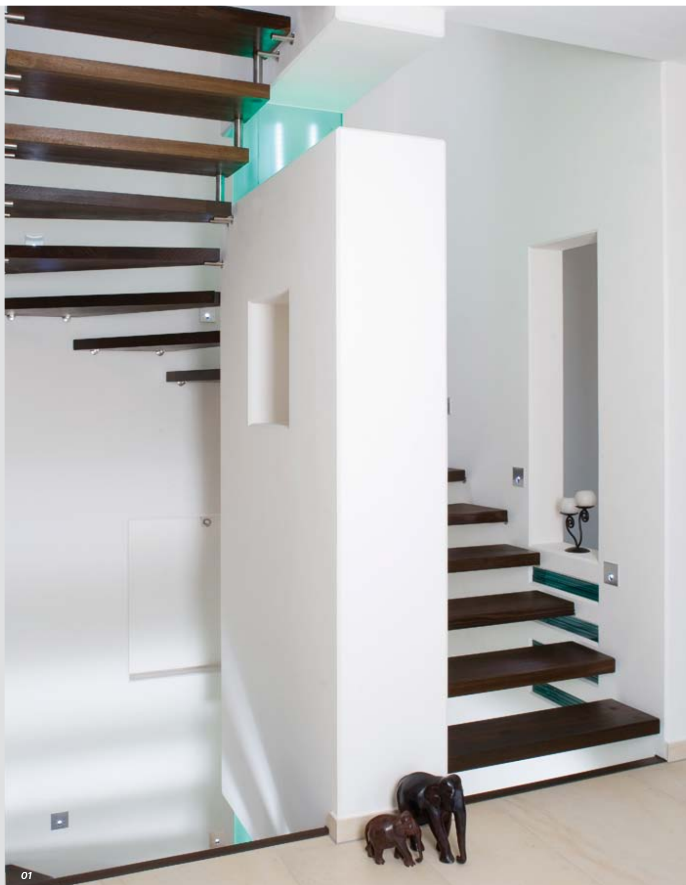
01-03_Trittstufen auf speziellen gummigelagerten Edelstahlbeschlägen, beidseitig in Massivwänden befestigt Holzart Eiche geräuchert
