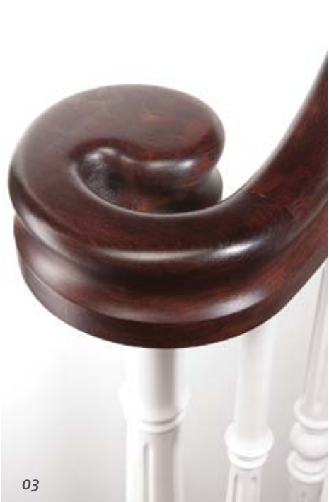
01+02+05_Handlaufkrümmling im Wendel 03_Handlauf auslaufend als Schneckenpfosten 04_Wangenkrümmling mit mitlaufendem Handlaufkrümmling
