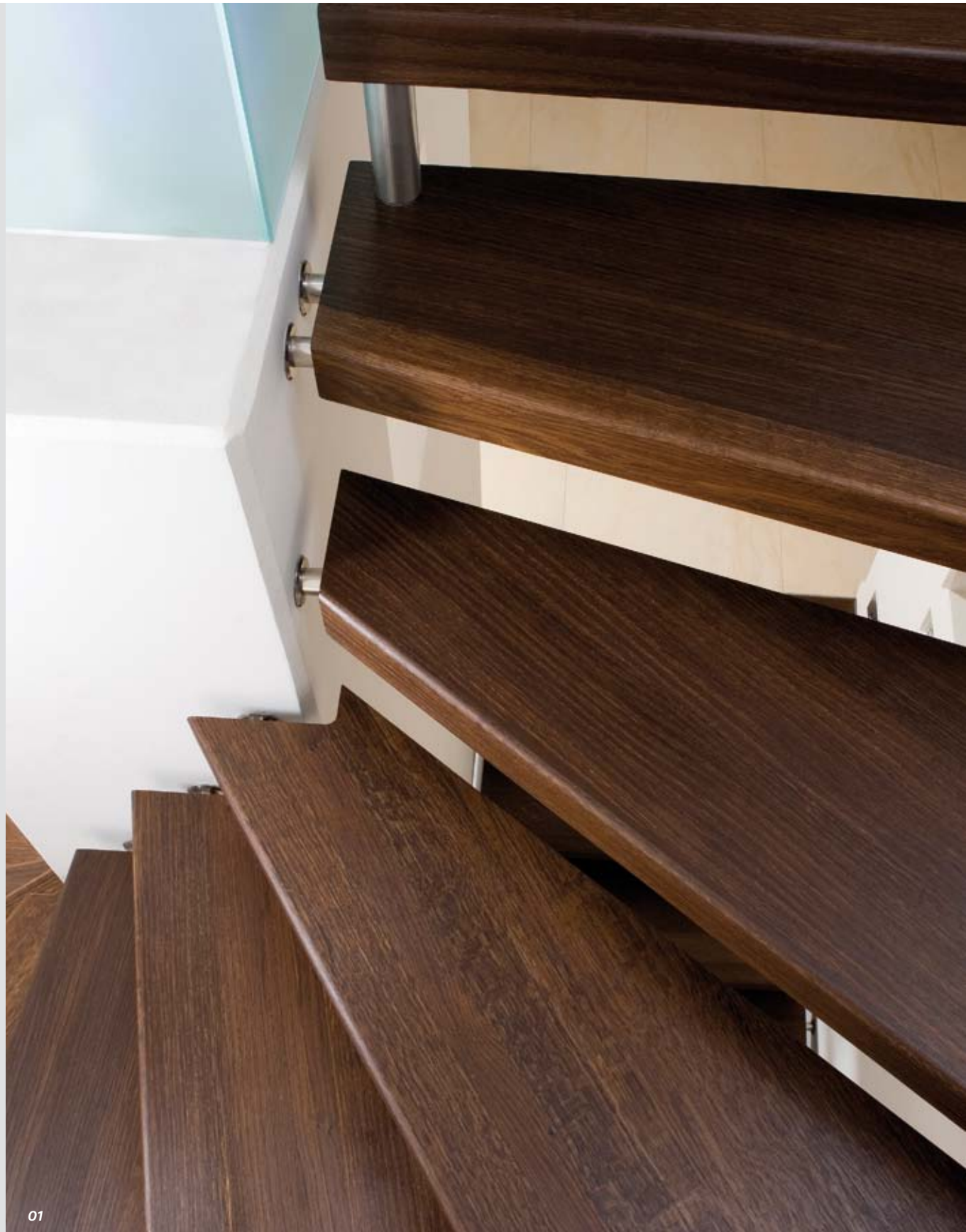
01_Auf Edelstahlbolzen gelagerte Stufen aus geräucherter Eiche
